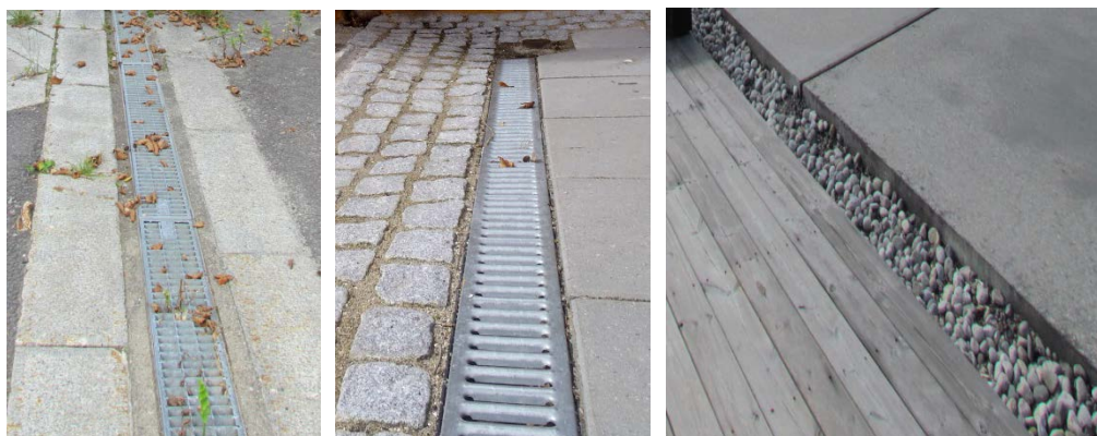
Figur 4: Eksempler på linjedræn og åbne drænrender med sten.
