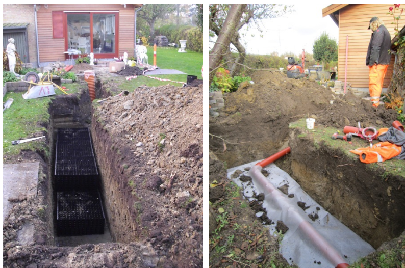
Figur 10: Plastfaskiner under anlæggelse
